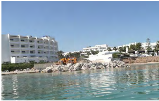
Figure 74: Construction d'un aménagement par déplacement de blocs rocheux en mer (G. Pergent)
